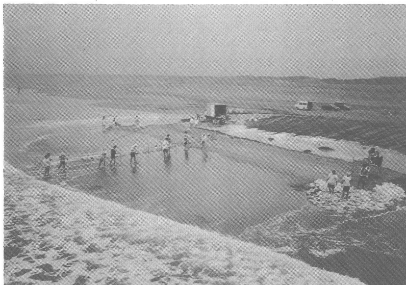
写真—4 人工前浜上での観測状況
