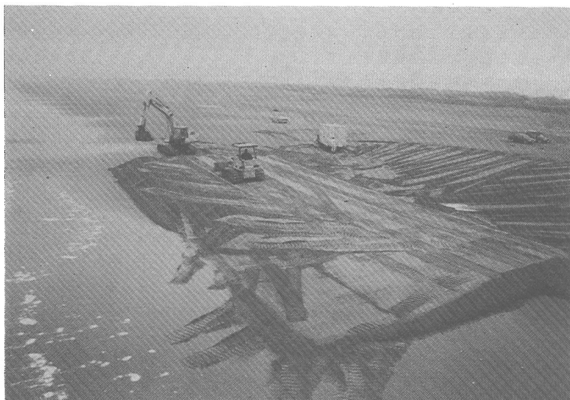
写真—1 バックフォーとブルドーザによる人工前浜の作成
