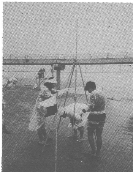
写真—3 簡易貫入試験機
