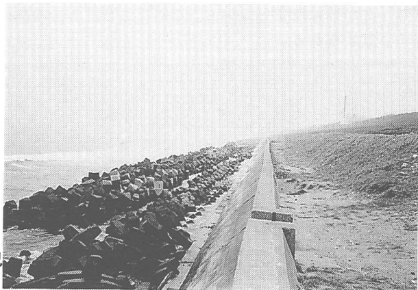
写真-4 護岸と消波工が続く大洗海岸の状況 (1996年5月11日撮影)
