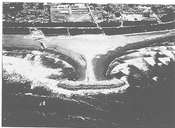
写真-5 茅ヶ崎のヘッドランドを正面から望む
