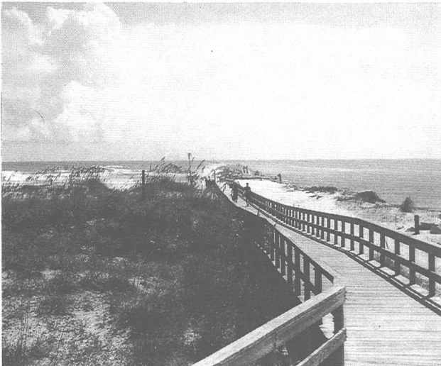
写真-5 ポンス・インレットの導流堤に続く遊歩道
