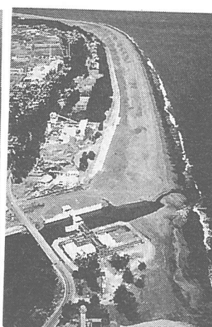
写真-7 栃山川河口部の状況 (1983 年 3 月 19 日撮影)
