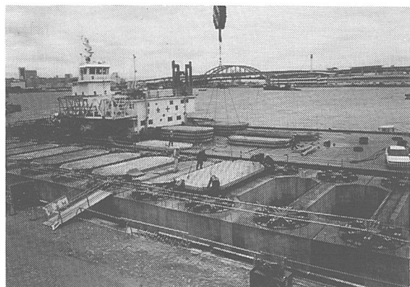
写真-4 床版ブロックの据付
