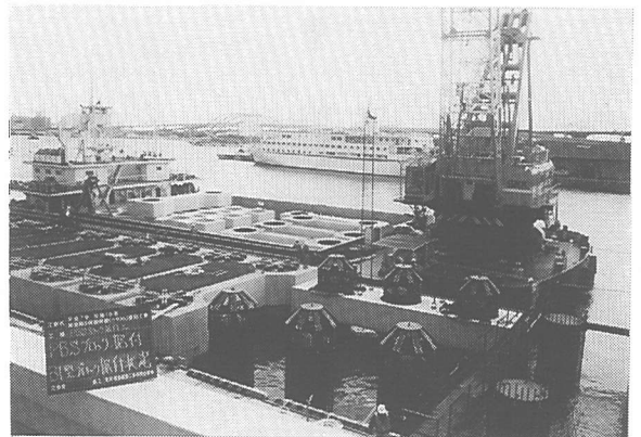
写真-2 プレキャストブロックの据付
