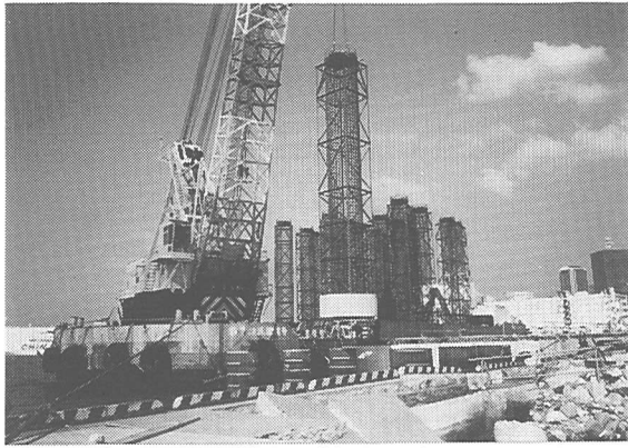
写真-1 補強枠を取付けたブロック受け
