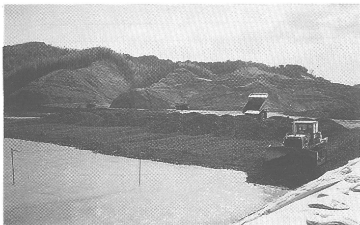
写真-4 二次埋立施工状況
