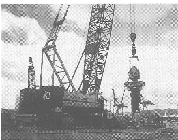
写真－２ 鋼管矢板打設工
