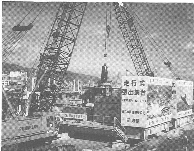
写真－１ 置換掘削工
