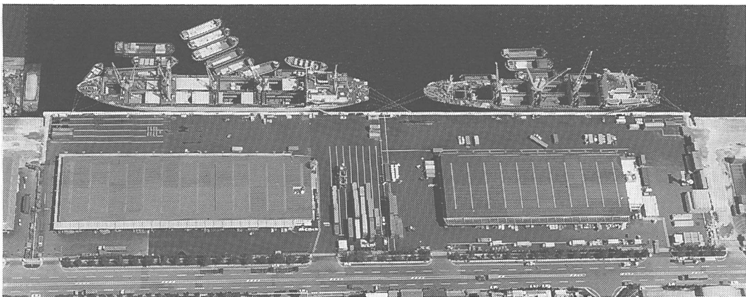
写真-3 竣工(1996年7月1日 第1船着岸)
