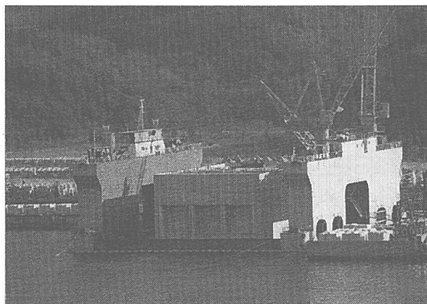
写真-1 ケーソン製作状況
