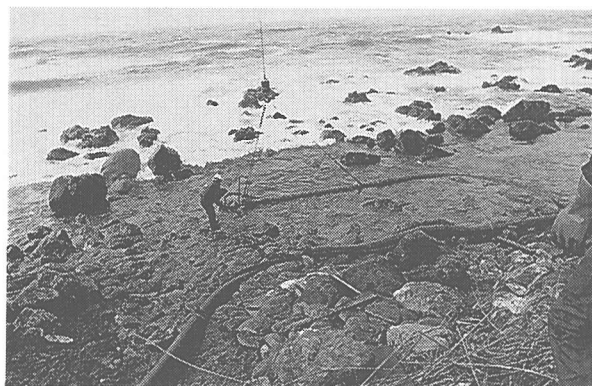
写真-6 ジェットポンプによる回収
