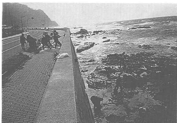
写真-7 人力による土のう袋の荷揚げ
