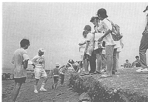
写真-6 下山川河口左岸に形成された浜崖
