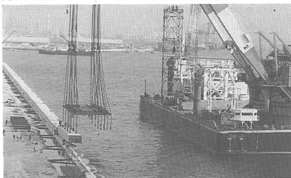
写真-4 上部工の据付
