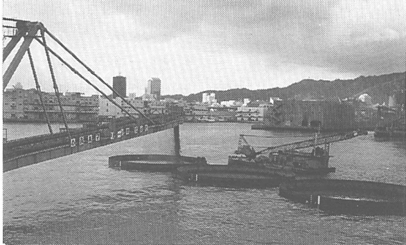
写真-2 中詰材投入
