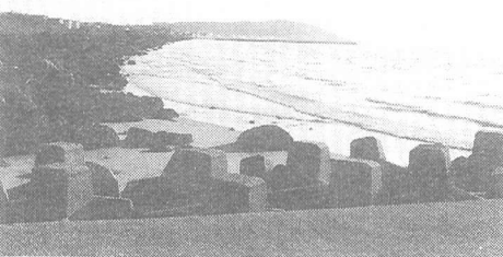
写真-8 梶栗川河口より南側の海岸状況 (1994年12月22日撮影)
