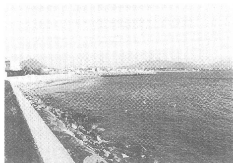
写真-5 安岡漁港の防波堤上手側での土砂堆積 (1994年12月22日撮影)
