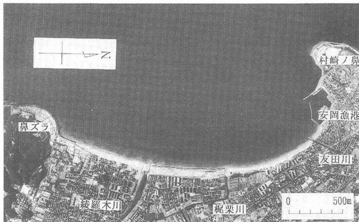
写真-1 綾羅木海岸の空中写真 (1981年撮影)
