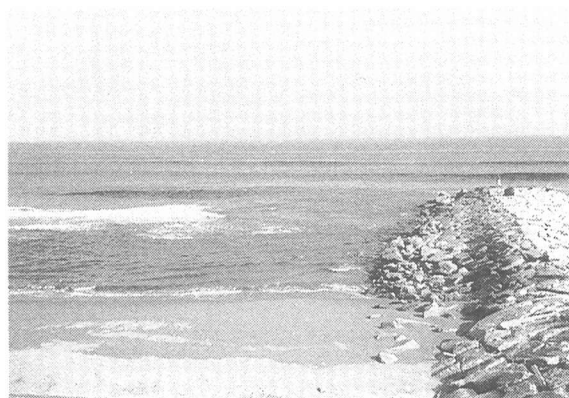
写真-1 2号ヘッドランドの北側側面における 離岸流の状況
