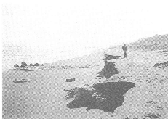
写真-9 3号ヘッドランドの南側隣接部における浜崖状況
