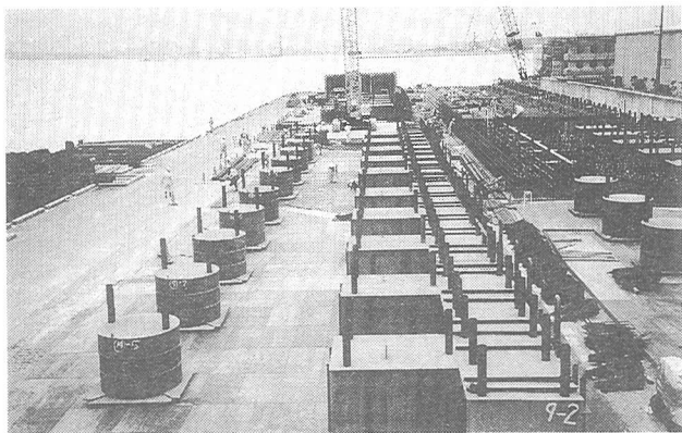
写真-2 栈橋上部エプレキャストブロックの箱抜き部と鉄筋の組立状況
