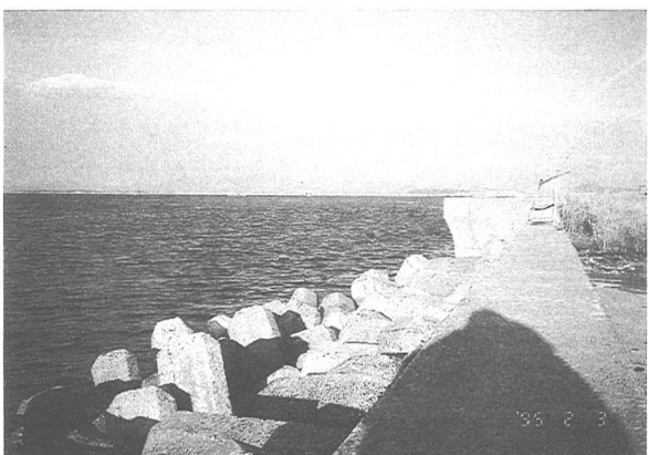
写真-3 若松の人工海岸 (垂直岸壁+消波ブロック)
