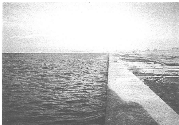
写真-4 若松の人工海岸(垂直岸壁)
