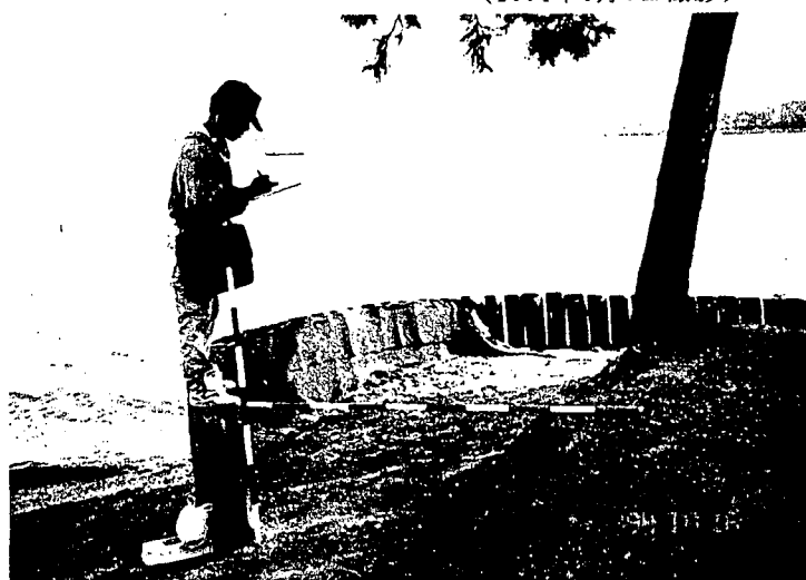
写真-5 木製護岸背後のうらだめ土砂の流出 (その1、1994年10月16日撮影)
