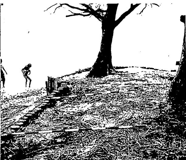
写真-10 護岸背後の越波状況 (1994年10月16日撮影)
