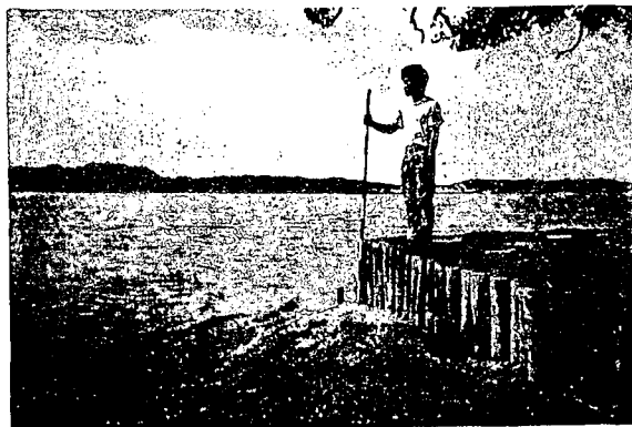
写真-10 砂嘴先端の木製護岸
