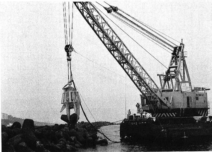
写真－3 海上実験状況
