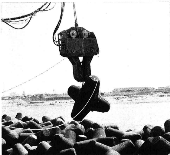
写真-2 吊り上げ状況
