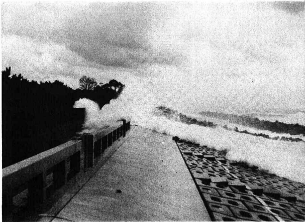
写真-1 緩傾斜護岸への打ち上げ状況(1)
