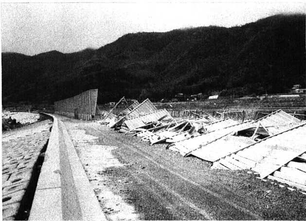
写真－４ 緩傾斜護岸背後の被災状況（２）
