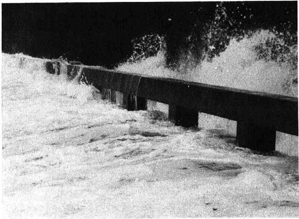
写真-2 緩傾斜護岸への打ち上げ状況(2)
