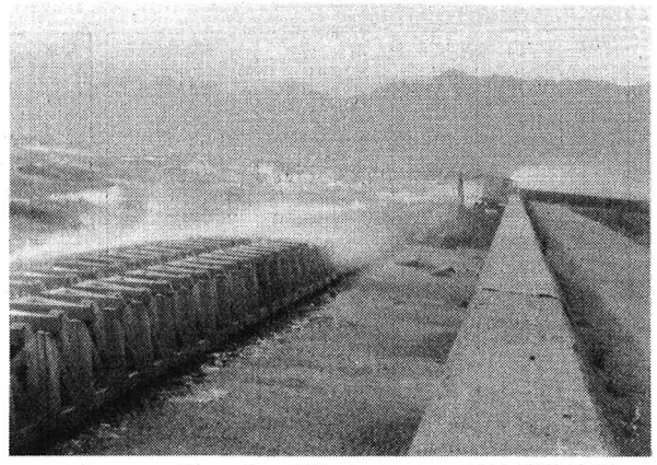
写真-6 捨て石+消波ブロックの現地消波状況
