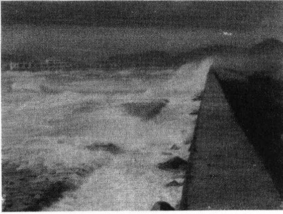
写真-5 捨て石マウンドの現地消波状況
