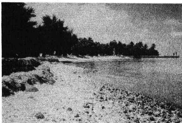
写真-13 東岸の突堤下手側の侵食された海浜
