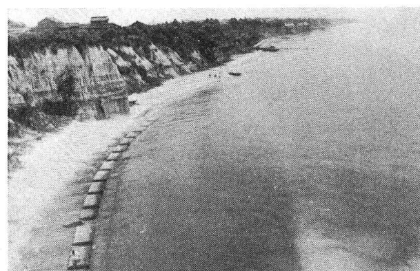
写真-4 海岸護岸の施工前の状況(1955年頃)
