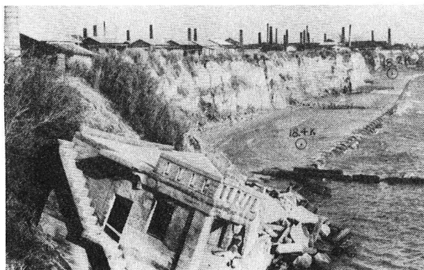
写真-2 江井ヶ島地先より東側の海食崖の状況(1953年)
