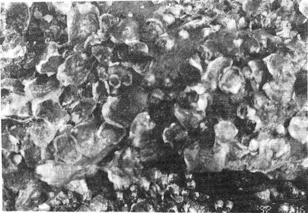
写真-1 堤体の石に付着した付着生物（外側）
