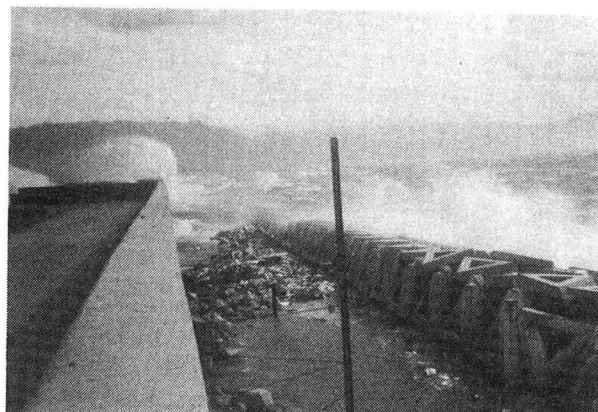
写真-3 遊水部付緩傾斜消波工の状況[図-3(c)]
