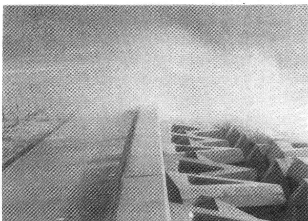
写真-1 台形断面消波工の越波状況[図-2(b)]
