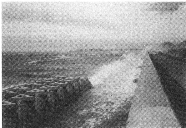
写真-2 遊水部付緩傾斜消波工の状況[図-3(b)]
