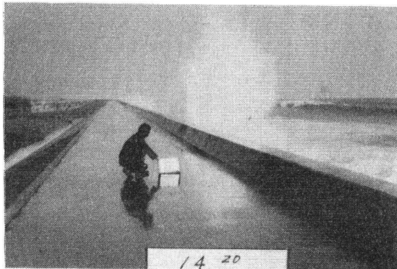
写真-6 静岡県の駿河海岸の海岸護岸の被災 (川尻地先)(1972年10月31日, 14:20)
