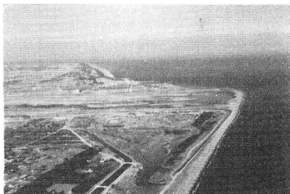
写真-3 静岡県の駿河海岸の空中写真 (川尻地先)(1970年12月11日)
