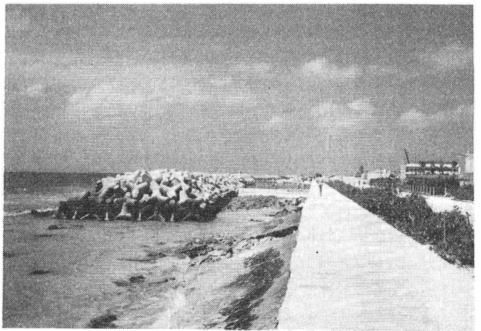
写真-5 マレ島南岸の第1号離岸堤
