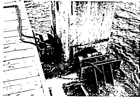
図-4 ローラー式フェンダー
