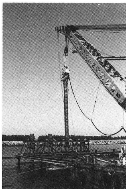
写真-1 鋼管打込み(一次打ち)状況
