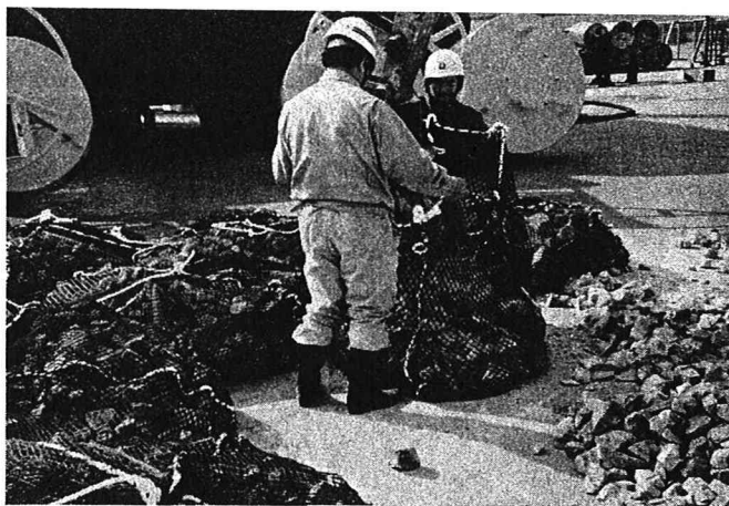
写真-1 F.U.の製作状況
