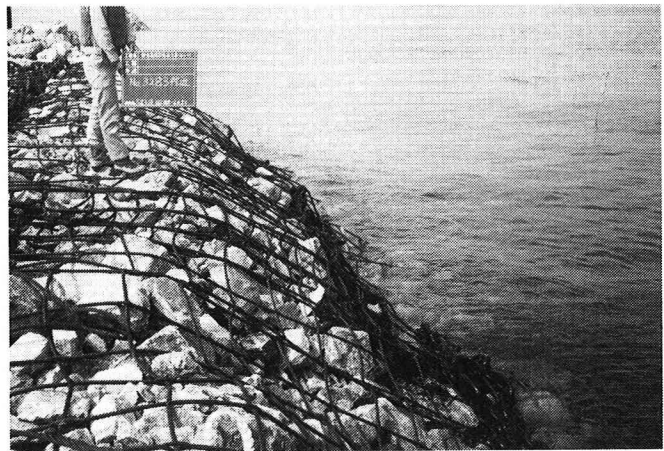
写真-6 ワイヤーネット被覆部分の状況
