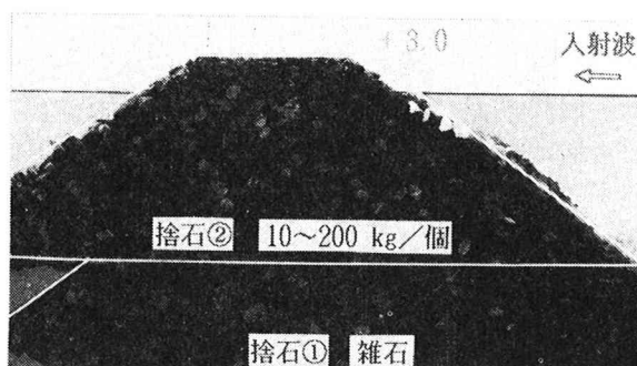
写真-3 ワイヤネット被覆時の護岸変形 (5時間波浪、設計断面)
