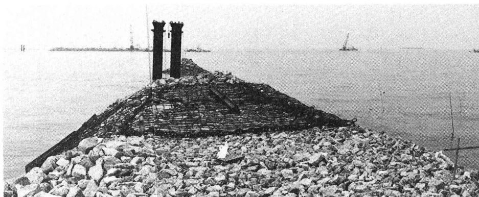
写真-4 現地のワイヤーネット被覆状況
