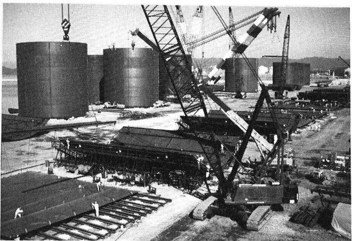
写真-1 鋼板セル製作状況
