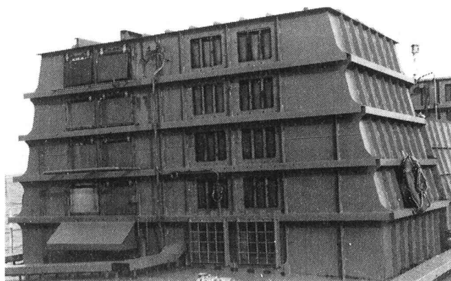
写真2 4枚弁方式発電装置の弁箱
