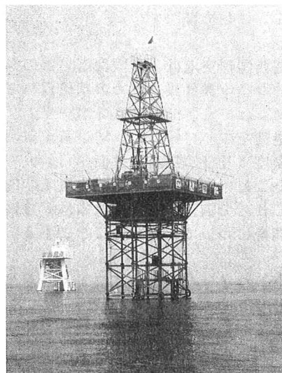
写真－1 足場やぐらの設置状況
