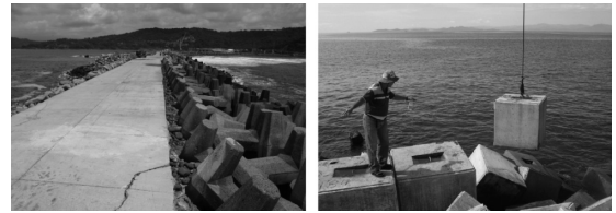
(a) 沖から見たドロス消波層 (b) 方塊の設置 (2005)
