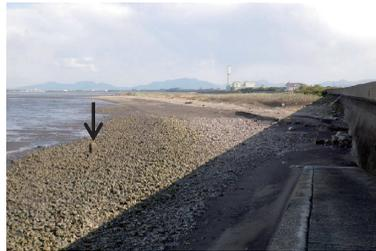
写真-12 斜路隣接部での砂の再堆積 (2009年11月2日)
