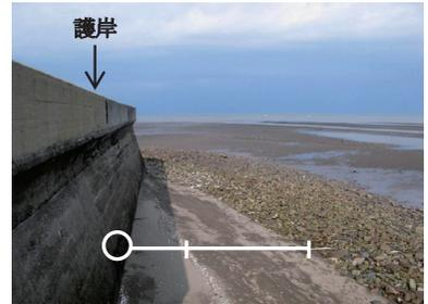
写真-1 直立護岸前面の砂浜 (2009年12月12日)
