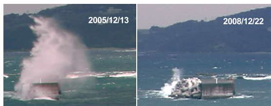
写真-2 飛沫の打上げの様子
