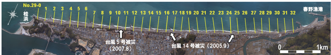
図-1 高知海岸の測線位置と被災箇所
