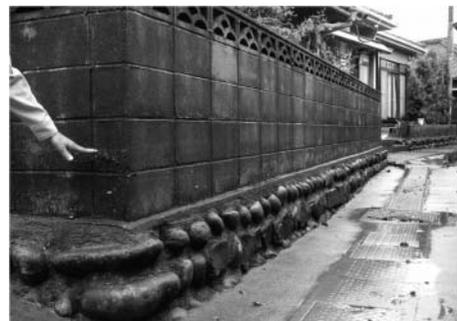
写真-1 住居の塀に残る浸水の痕跡(瀬上地区)
