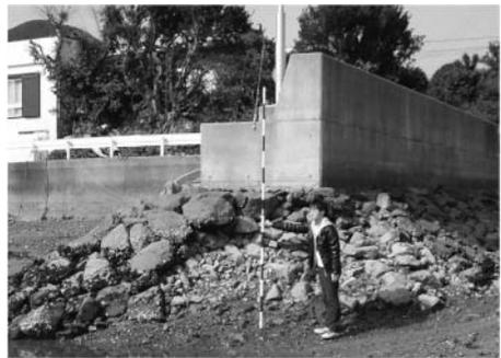
写真-8 被覆石が流出した突堤基盤部先端 (瀬上地区, 2月28日)
