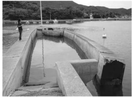
写真-6 破壊した堤防 (小島地区, 2008年10月6日)
