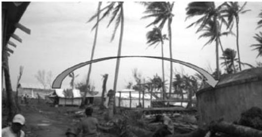
写真-5 200m近く移動したコンクリート製貯水槽（Lwaza 村）
