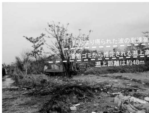
写真-5 Thilewaa Portでの高潮遡上
