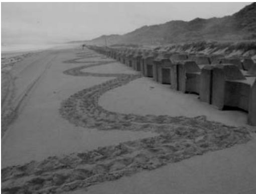
写真-2 消波ブロックによる産卵の阻害例
