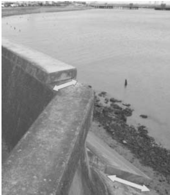
写真-2 名古屋港海岸の補修状況（矢印：補修部分）
