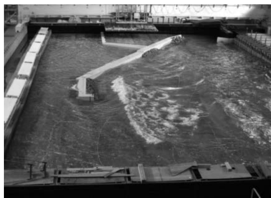
写真-1 堤頭部の安定実験状況
