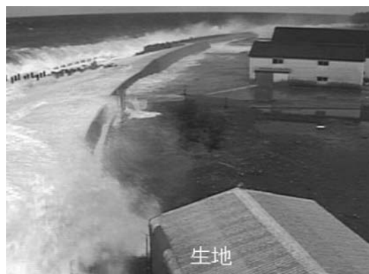
写真-3 生地地区の越波の状況
