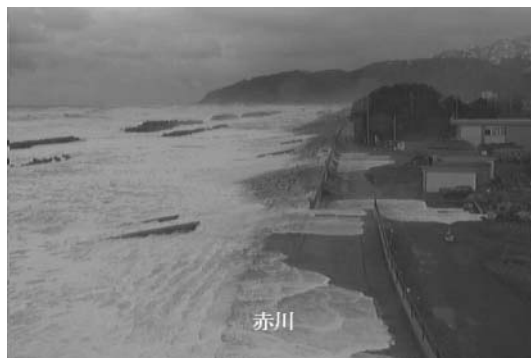
写真-6 赤川地区の越波の状況
