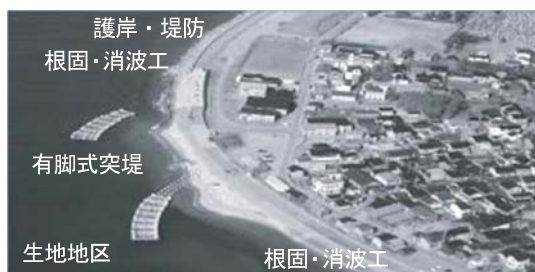
写真-2 生地地区の海岸保全施設
