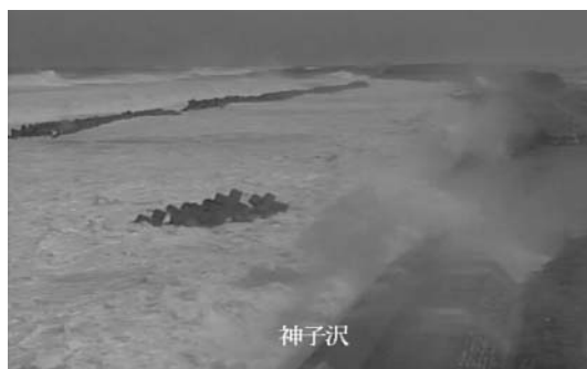
写真-4 神子沢地区の越波の状況
