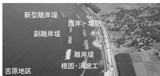
写真-1 吉原地区の海岸保全施設
