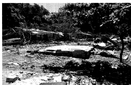
図-2 マラケラバ3における被災状況
