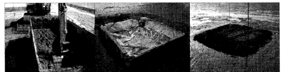
干潟材料攪拌混合状況 施工時の型枠と防砂シート 施工完了時の実験施設 St.8
