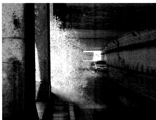
写真-2 覆道開口部からの越波状況
