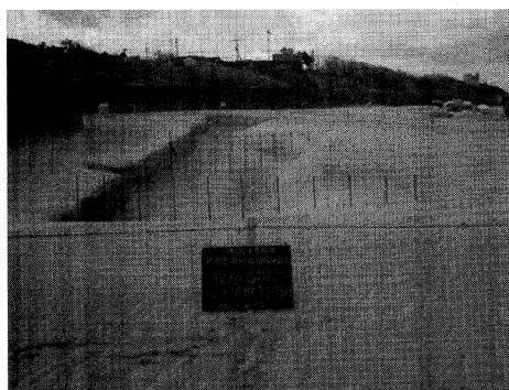
写真-4 第3回測量時（2月18日撮影，測線D側より）
